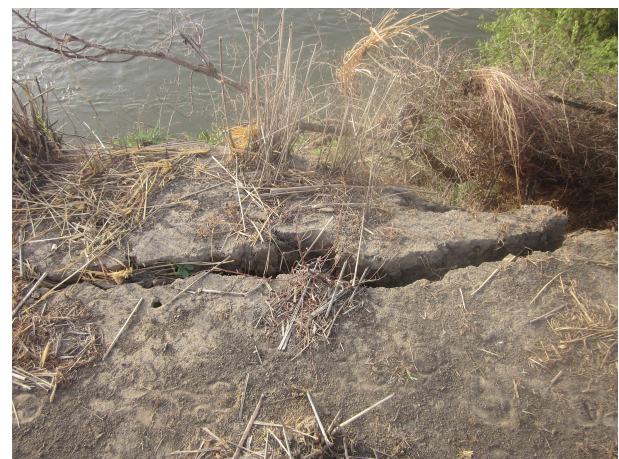
Figure 2. Amorce de déstabilisation d'une berge non loin de Koukoum, 9° 18' 22.76" N-12° 59' 43.99" E. Cliché : Félix Mbélé Abbo.
